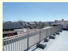
屋上手すり部分
