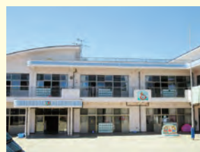
屋上前面の取付部
