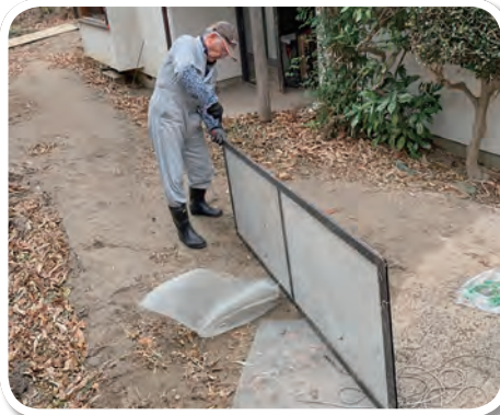
小川地区：網戸の解体作業
