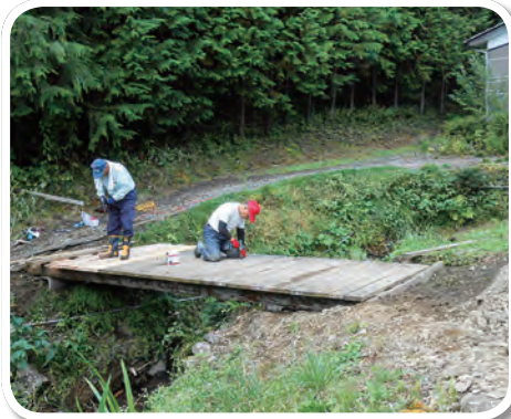
遠野地区：橋の復旧作業
